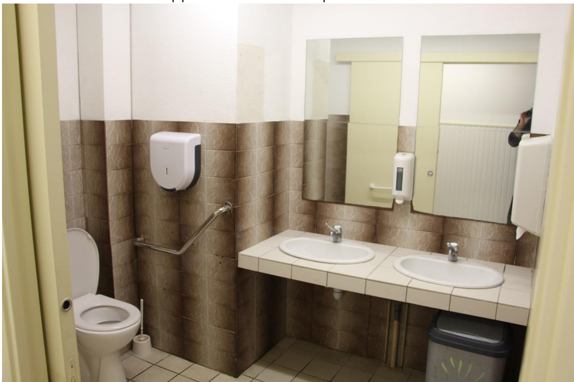
Pose d'une barre d'appui conforme et repositionnement des accessoires
