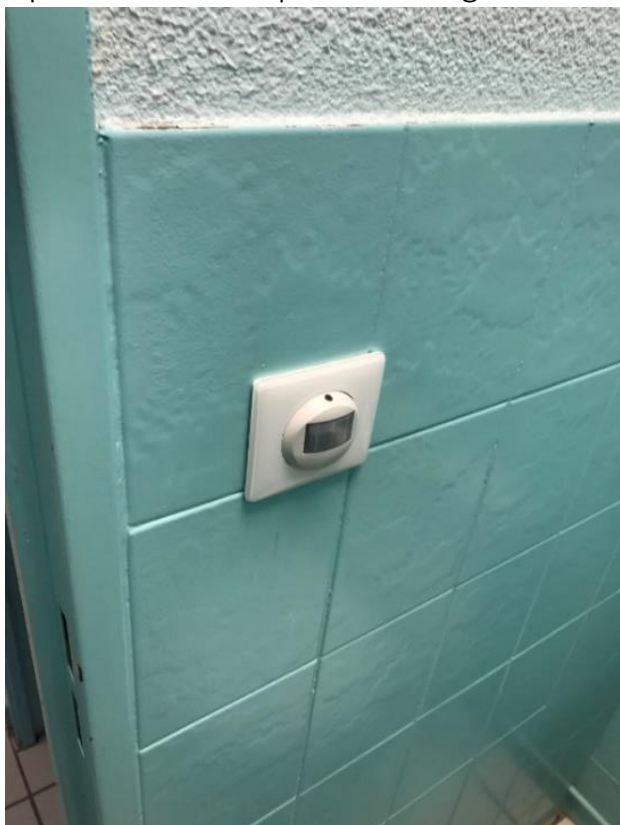
Dispositif automatique d'allumage des WC ainsi que le hall d'entrée dans les sanitaires
