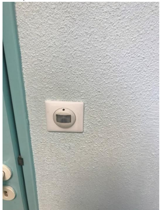
Dispositif automatique d'allumage des WC ainsi que le hall d'entrée dans les sanitaires
